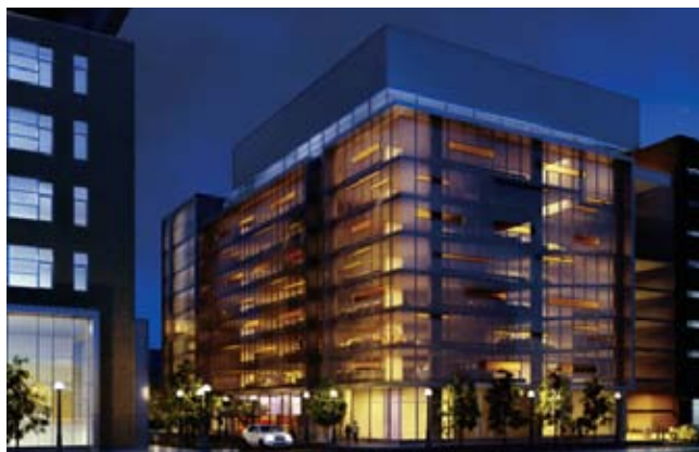
L'édifice de services publics et de stationnement vu de nuit
